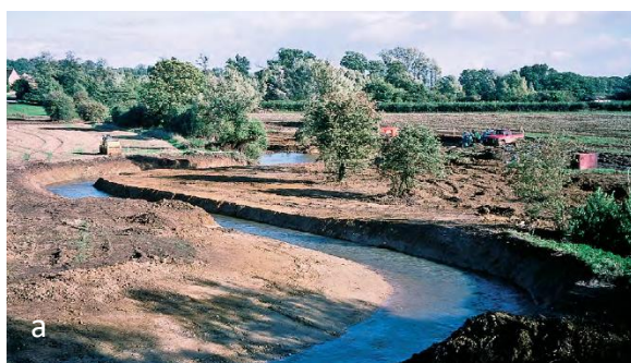
Obr.C.4 Revitalizácia rieky Cole (UK) - pohľad na novovytvorené premeandrované koryto: a) počas výstavby, b) 2 roky po realizácii (1997)
