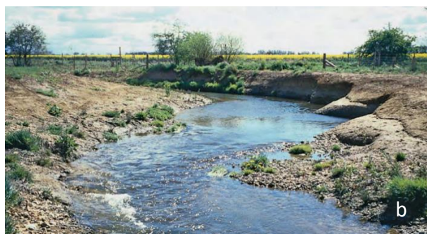
Obr.C.4 Revitalizácia rieky Cole (UK) - pohľad na novovytvorené premeandrované koryto: a) počas výstavby, b) 2 roky po realizácii (1997)
