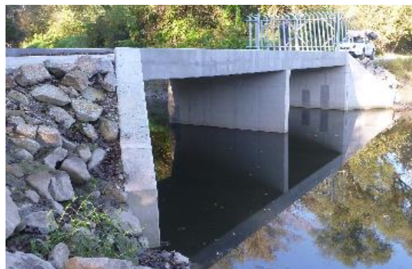
Priepust na sprietochennom devínskom ramene – umožňuje migráciu rýb a vodnej bioty
