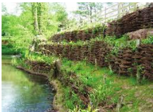
Obr. 10.14 Viacradové zápleťové vrbové plôtiky na zabezpečenie stability brehov
