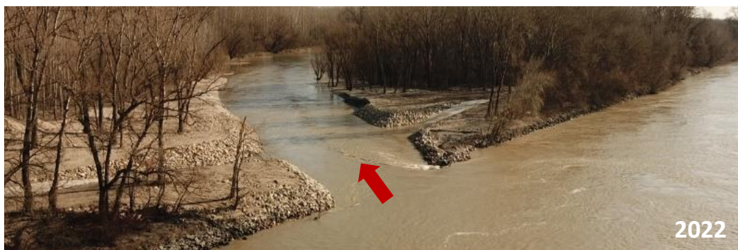
Obr. D.1 Kľúčovecké rameno – sprietočnené v roku 2019
