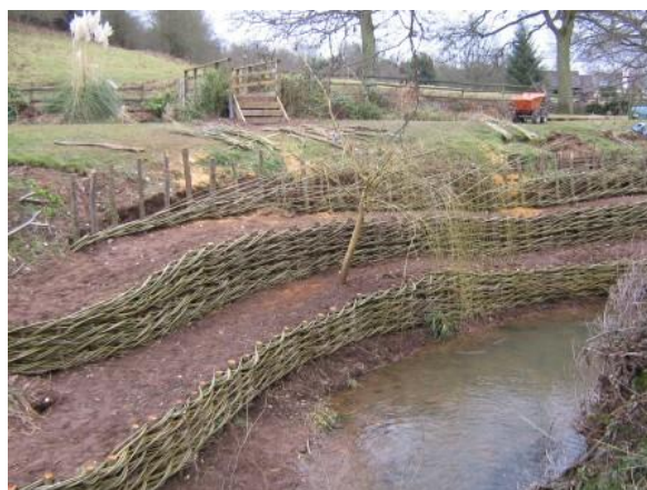
Obr. 10.14 Viacradové zápleťové vrbové plôtiky na zabezpečenie stability brehov
