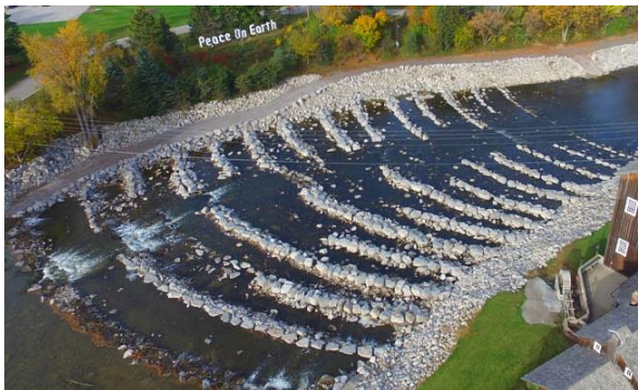
Celokorytová rampa na priehrade Frankenmuth / rieka Cass
