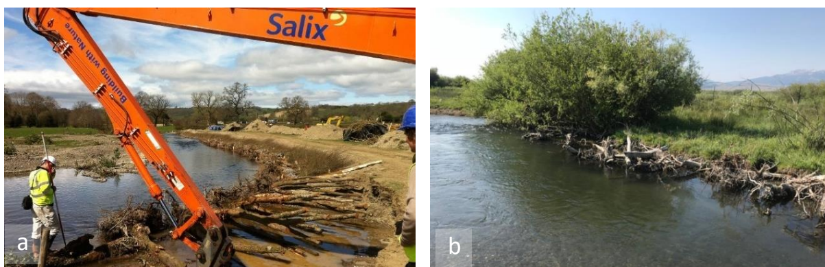
Obr.5.17 Inštalácia veľkých drevených prvkov do päty svahu konkávneho oblúku (a), veľké drevené prvky mŕtve dreva osadené v brehu na sprírodnenie brehov (b)
