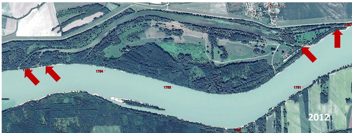
Obr. D.10 Velkolélsky ostrov – stav pred otvorením ramien – všetky ramená boli oddelené od koryta na úrovni výšky brehovej línie
