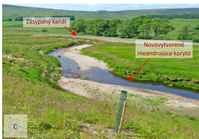
Obr.C.5 Schéma revitalizácie rieky Highland Water (a); vytvorené koryto rieky vzniklo vyťažením sedimentov z pôvodného meandrujúceho toku – 09/2012, (b); pohľad na obnovené koryto po roku – 07/2013, pôsobenie procesov transportu a sedimentácie umožnilo formovanie koryta a korytových makro-útvarov– lavíc. (RRC, 2019)
