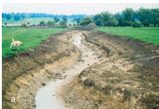
Obr.C.2 Vytvorenie nového meandrujúceho koryta, ktoré zároveň umožňuje častejšie zaplavovanie inundačného územia na rieke Cole (UK), a) počas výstavby, b) 2 roky po realizácii (RRC)
