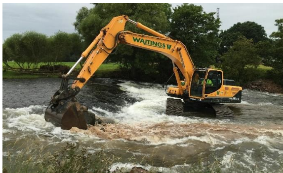
Odstránenie bariéry na rieke Cumbria – revitalizácia rieky
