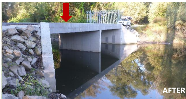
Obr. D.5 Rúrový priepust nahradený veľkorozmernými rámovými priepustmi, rozšírenie koryta v tomto profile
